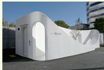
西参道公衆トイレ
